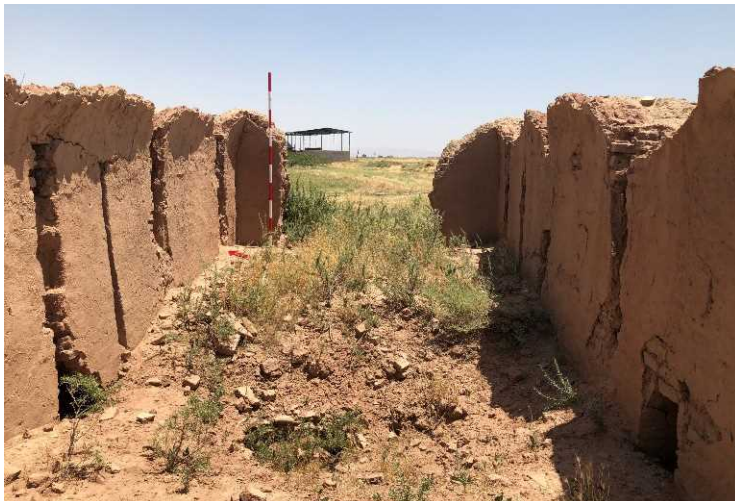
• تصویر ۵- نمای داخلی بنای کوره گلدروستای حیدرآباد با دودکش‌ها (دید از غرب).
